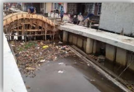
Gambar 7. Sampah Palastik yang Menyumbat Aliran Parit
